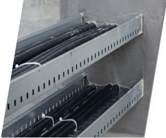
КАБЕЛЬНЫЕ ОГНЕЗАЩИТНЫЕ ПРОХОДКИ ОГНЕТИТАН-КП
